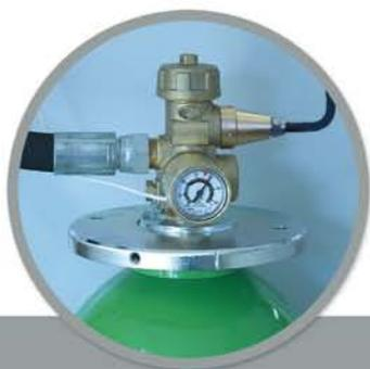
Bombola con agente estinguente DEFInert che agisce sul principio dell'inertizzazione con scarica a lenta diffusione all'interno dell'armadio.
